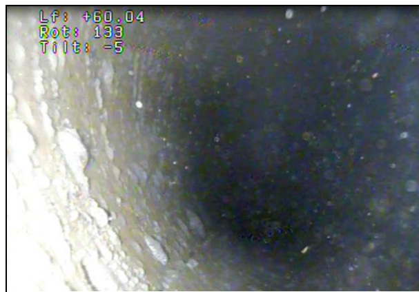
Photo 6 : Tube avec concrétions à 60 m
