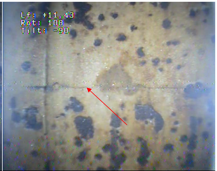
14 - Tubage acier en Ø 550 mm, soudure n°7
