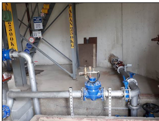
Photo 4 : Refoulement du captage et caniveau technique
