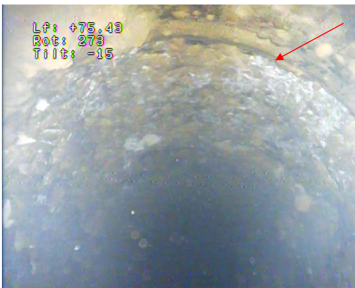
68 - Partie basse du forage non tubée
