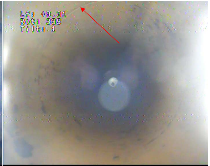
12 - Tubage acier en Ø 550 mm, soudure n°6
