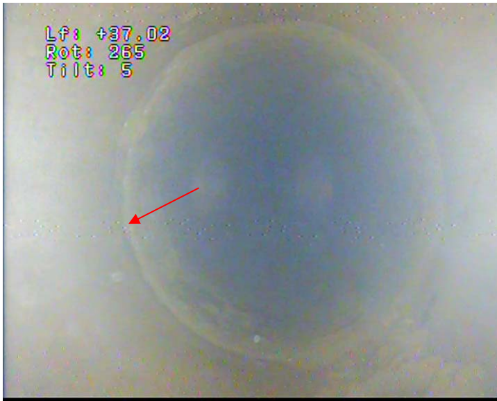
29 – Réduction tubage acier en Ø 550 / 500 mm
