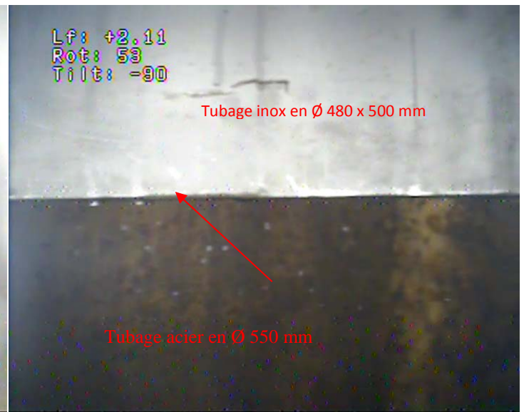
4 – Base du tubage inox en Ø 480 x 500 mm
