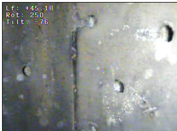
Photo 3 : Début des crépines à 45 m
