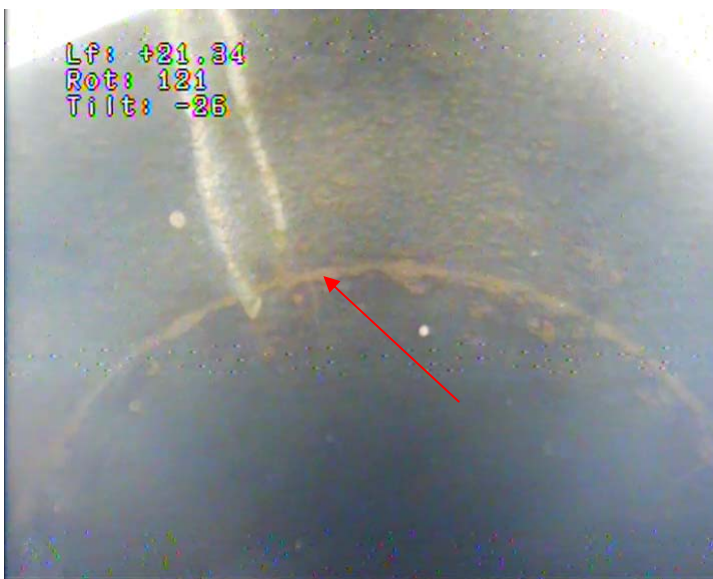
21 – Tubage acier en Ø 550 mm, soudure n°14
