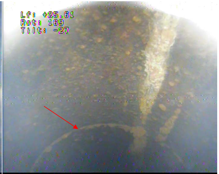
24 - Tubage acier en Ø 550 mm, soudure n°17
