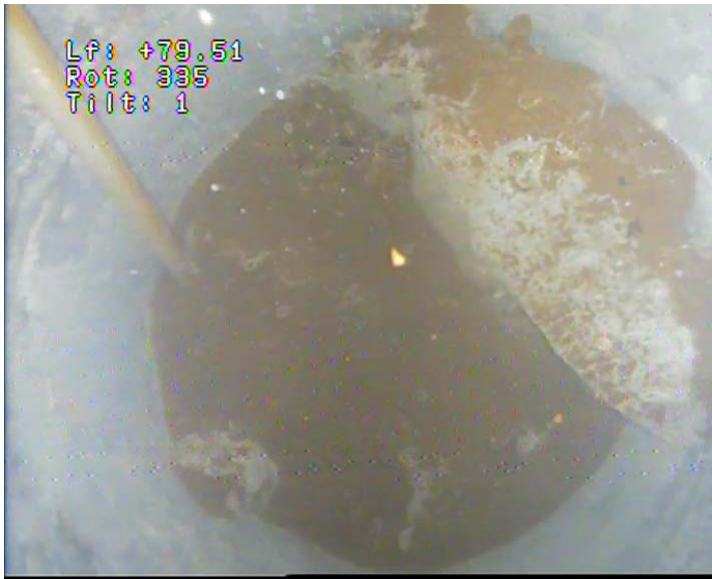
70 – Fond de l'ouvrage – Tuyau perdu
