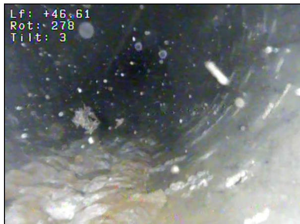
Photo 4 : Tube concrétionné à 46,6 m
