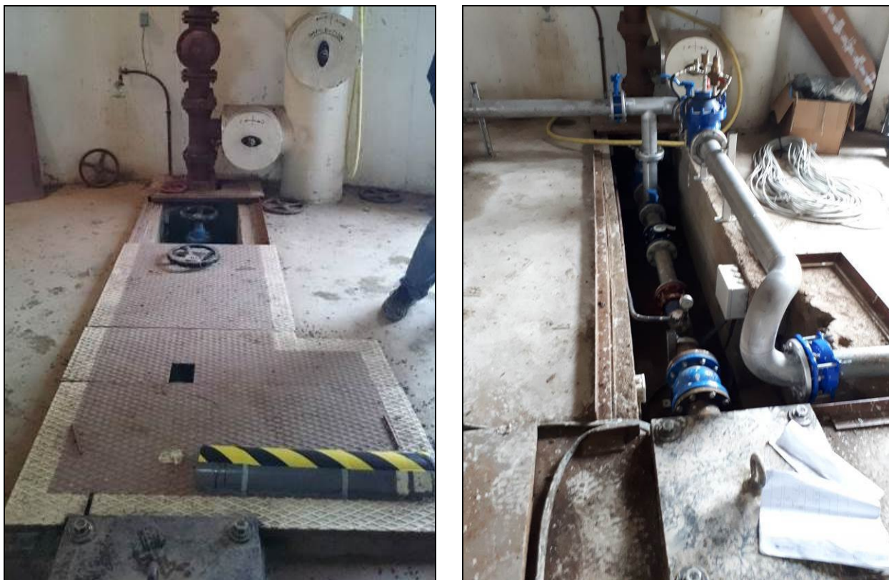
Figure 7 : Refoulement du captage et caniveau technique
