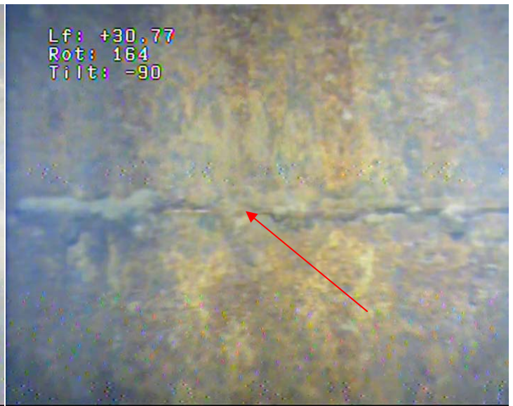
26 - Tubage acier en Ø 550 mm, soudure n°20
