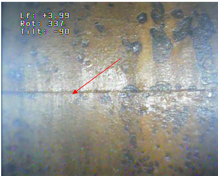
7 - Tubage acier en Ø 550 mm, soudure n°2
