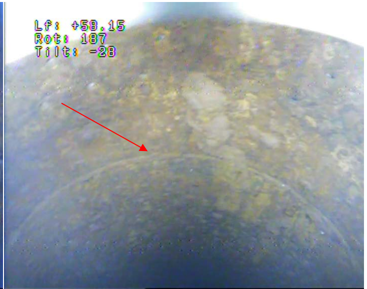
50 – Tubage acier en Ø 500 mm, soudure n°36
