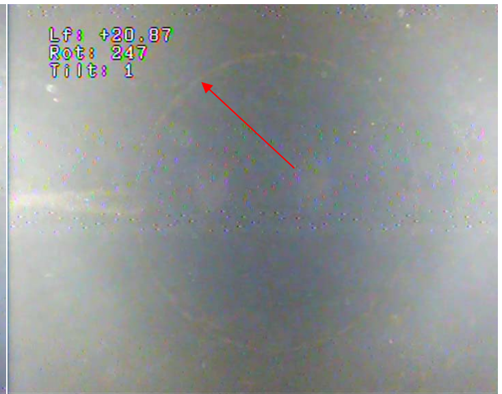
20 - Tubage acier en Ø 550 mm, soudure n°14
