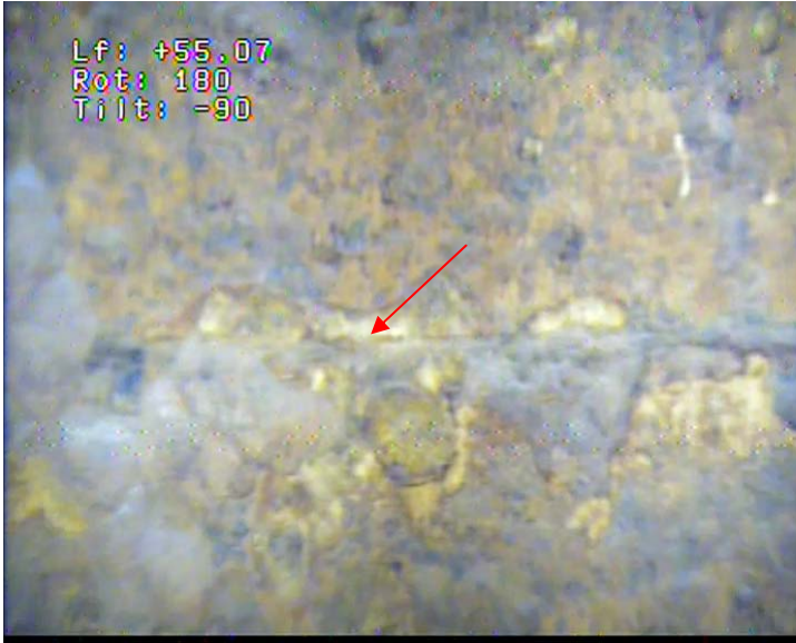
47 – Tubage acier en Ø 500 mm, soudure n°34
