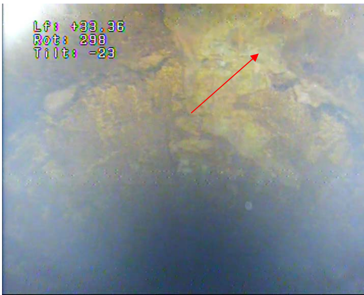
27 – Tubage acier en Ø 550 mm, soudure n°22
