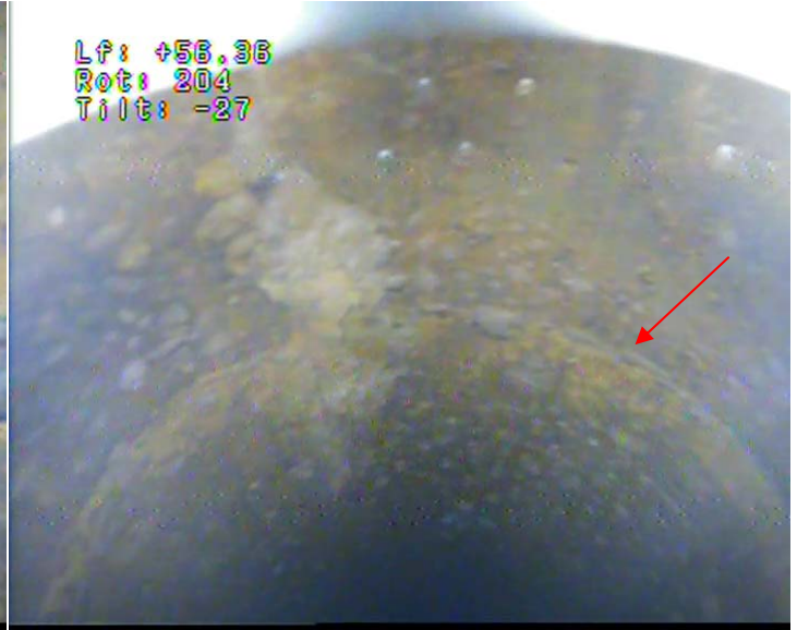
48 – Tubage acier en Ø 500 mm, soudure n°35
