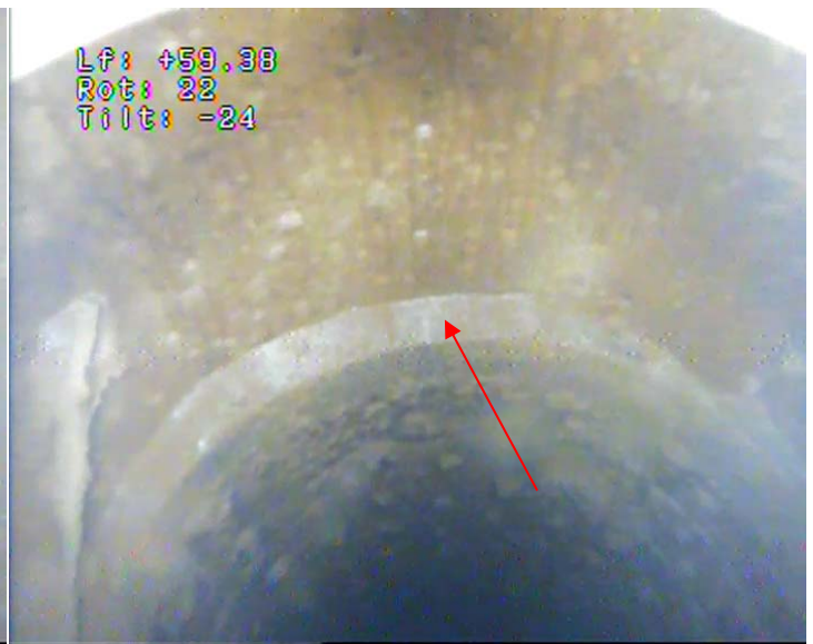
52 – Réduction tubage acier en Ø 500 / 450 mm
