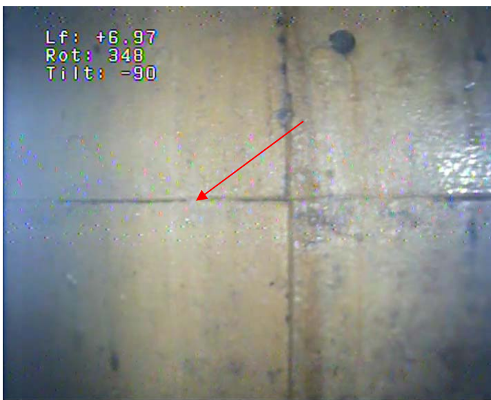
9 - Tubage acier en Ø 550 mm, soudure n°4
