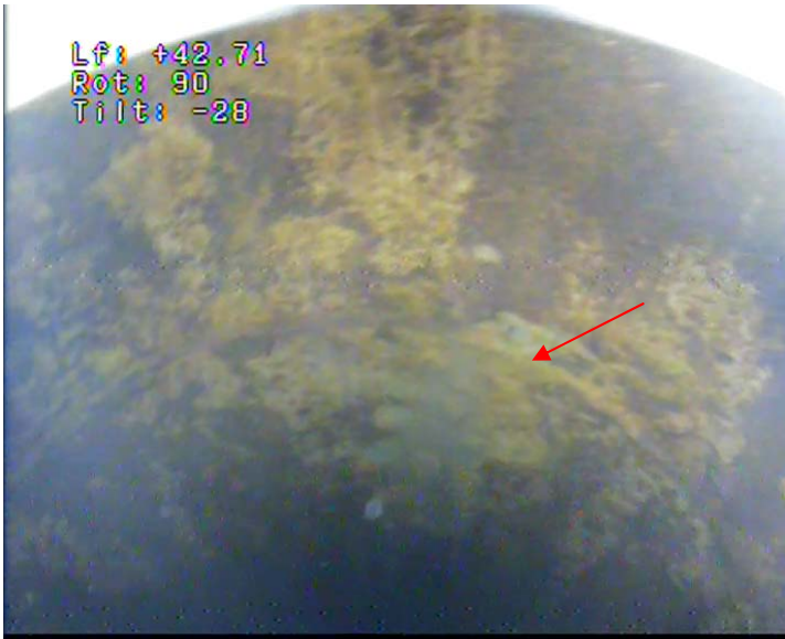
35 – Tubage acier en Ø 500 mm, soudure n°27
