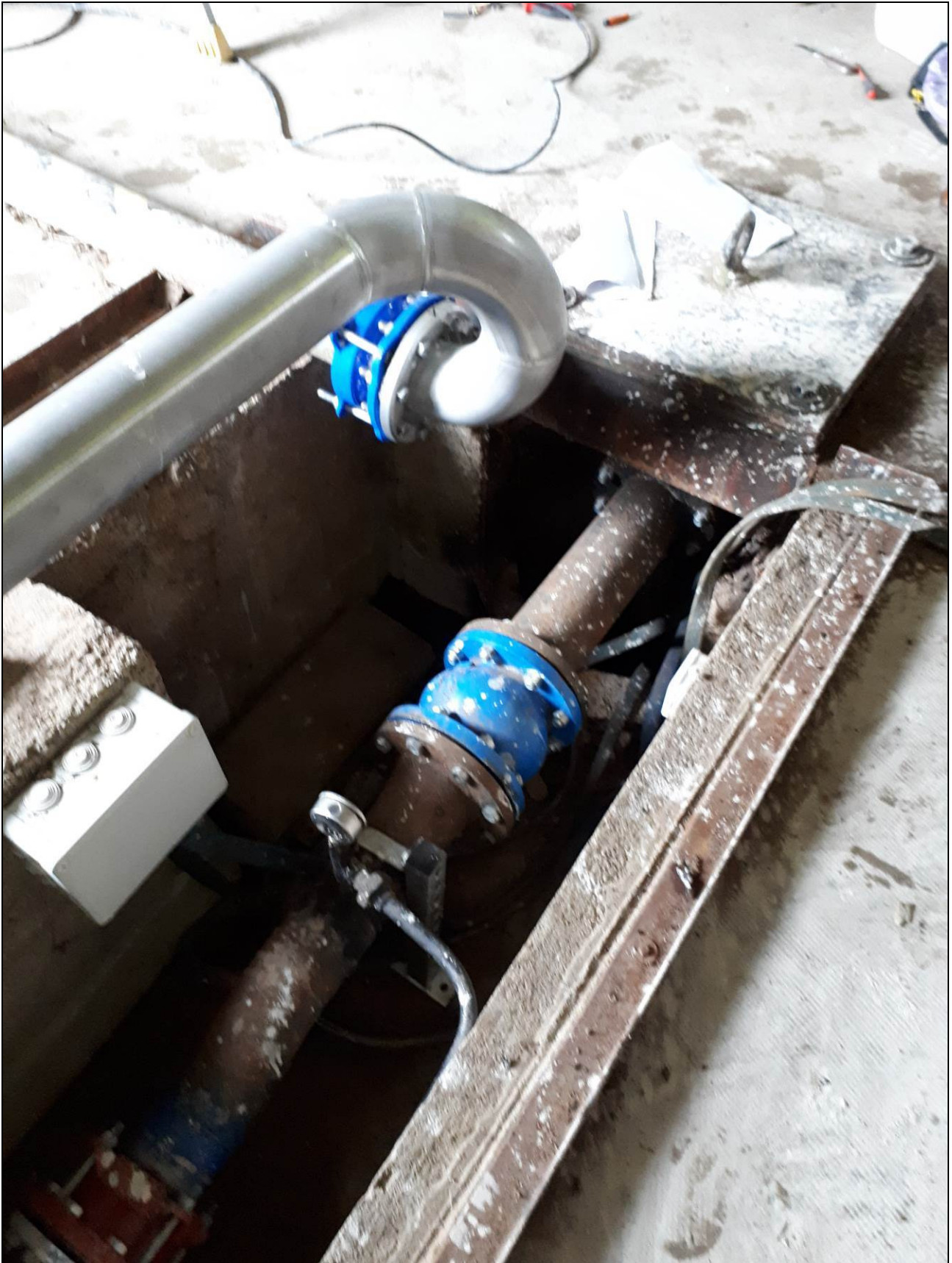
Figure 2 : Tête de puits avant travaux (Février 2018)
