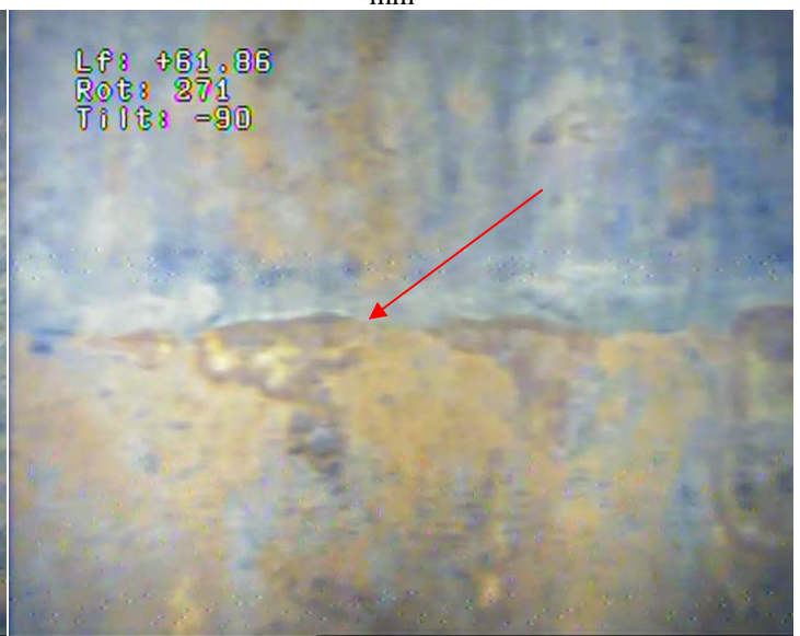
57 – Tubage acier en Ø 450 mm, soudure n°37
