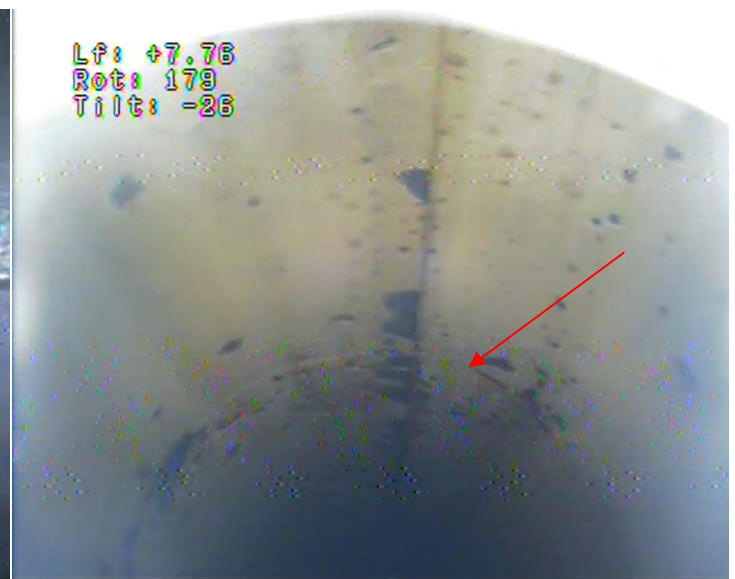
10 - Tubage acier en Ø 550 mm, soudure n°5
