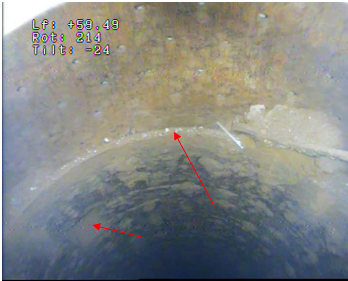
53 – Réduction tubage acier en Ø 500 / 450 mm Trou de manœuvre
