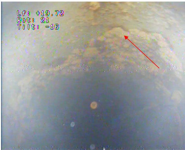
19 – Concrétions de carbonate de calcium
