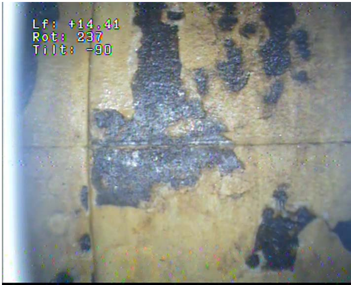
17 – Tubage acier en Ø 550 mm, soudure n°9
