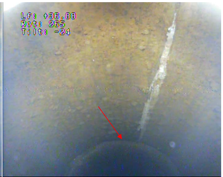
28 – Réduction tubage acier en Ø 550 / 500 mm
