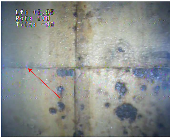
13 - Tubage acier en Ø 550 mm, soudure n°6
