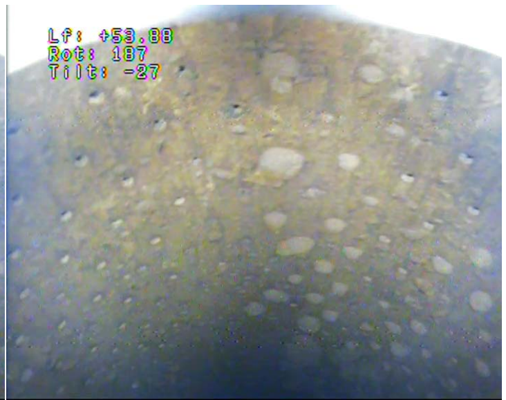
46 – Crépines partiellement colmatées
