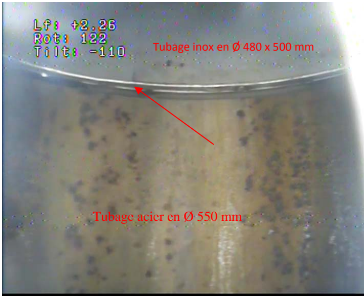
5 - Base du tubage inox en Ø 480 x 500 mm
