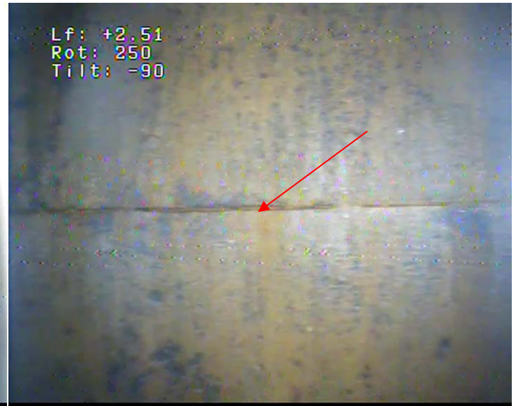
6 - Tubage acier en Ø 550 mm, soudure n°1
