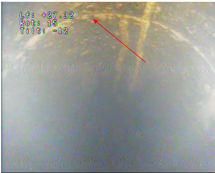
25 – Tubage acier en Ø 550 mm, soudure n°18
