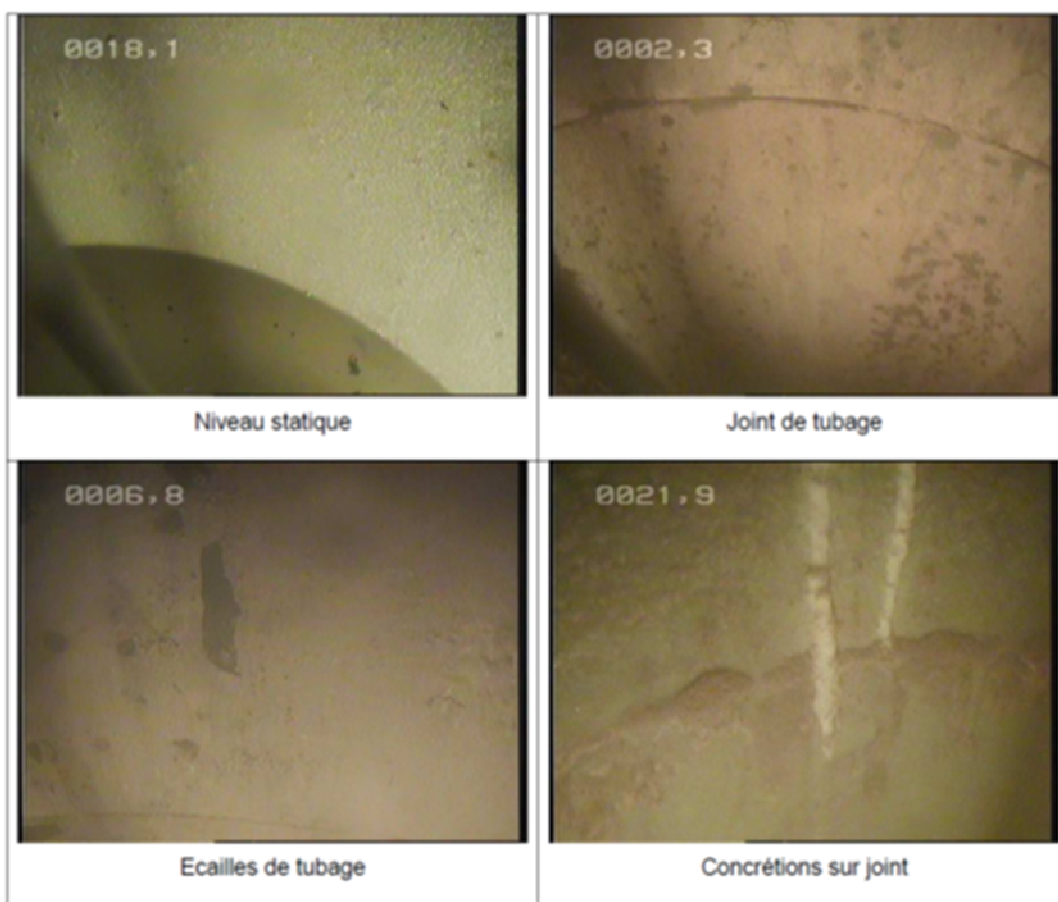
Figure 10 : État de l'ouvrage 1
