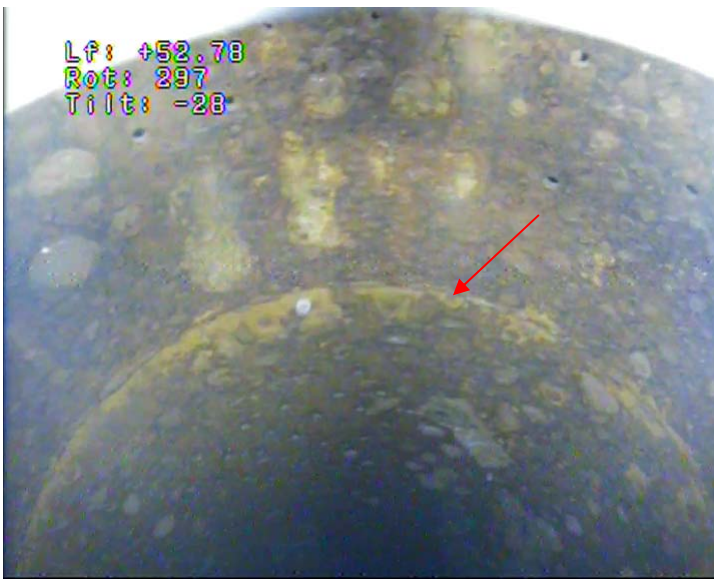
45 – Crépines partiellement colmatées, soudure n°33
