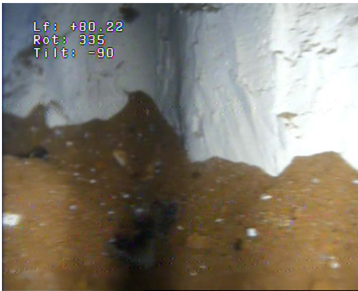
72 – Fond de l'ouvrage
