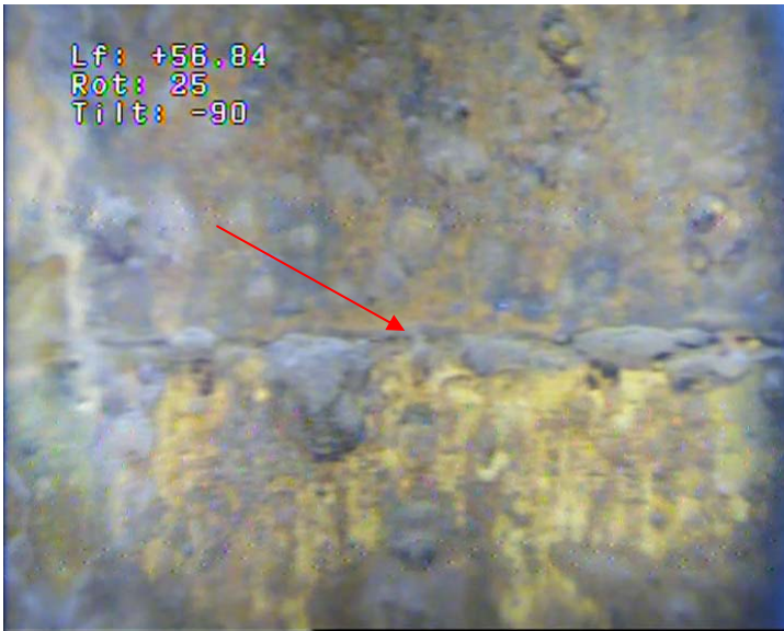
49 – Tubage acier en Ø 500 mm, soudure n°35
