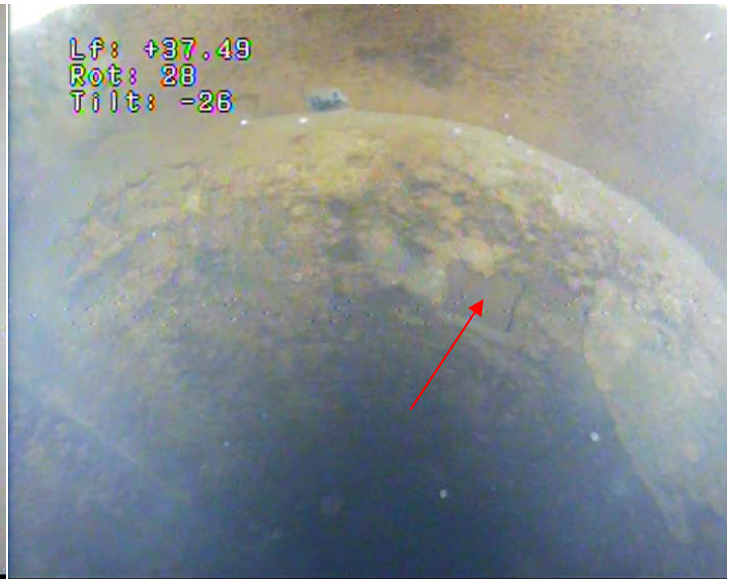
30 – Réduction tubage acier en Ø 550 / 500 mm Trou de manœuvre
