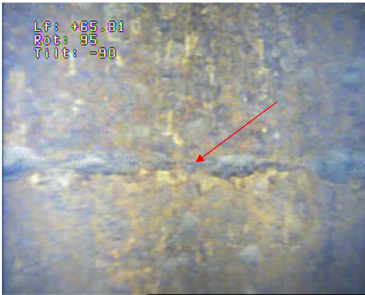
60 – Tubage acier en Ø 450 mm, soudure n°37
