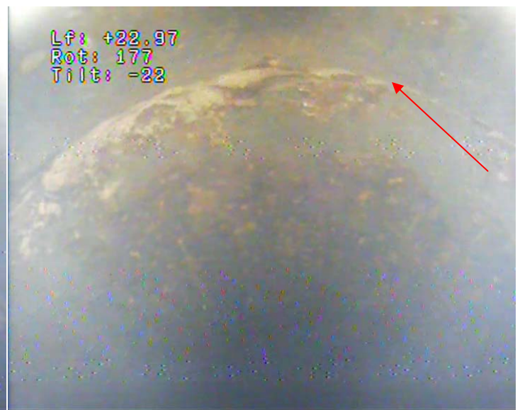
22 - Tubage acier en Ø 550 mm, soudure n°15
