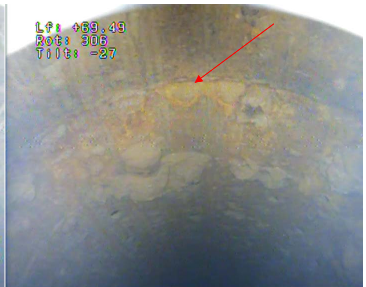
63 – Tubage acier en Ø 450 mm, soudure n°41
