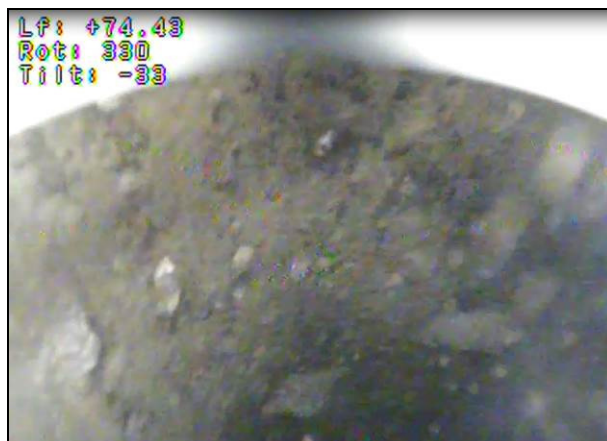
Photo 8 : Crépines colmatées à 74 m
