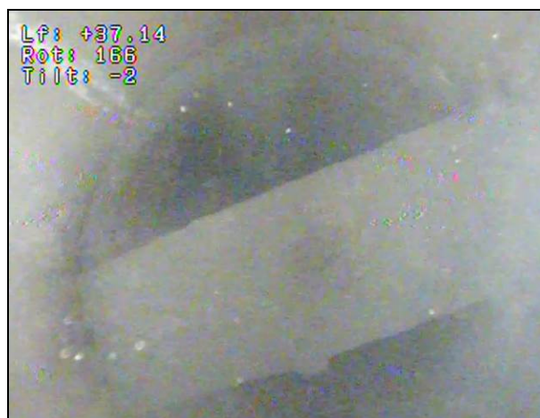
Photo 2 : Réduction tubage acier en ø 550/500 mm avec planche à 37,6 m
