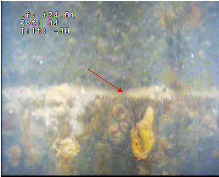
23 – Tubage acier en Ø 550 mm, soudure n°16
