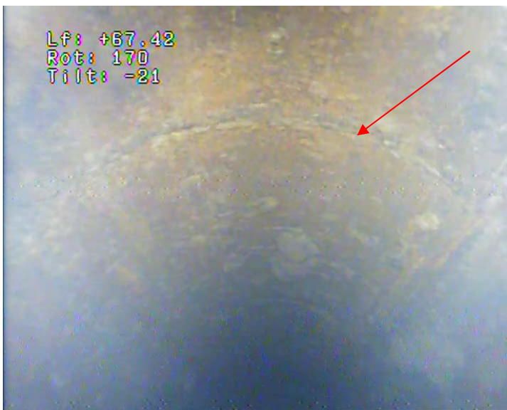
62 – Tubage acier en Ø 450 mm, soudure n°40
