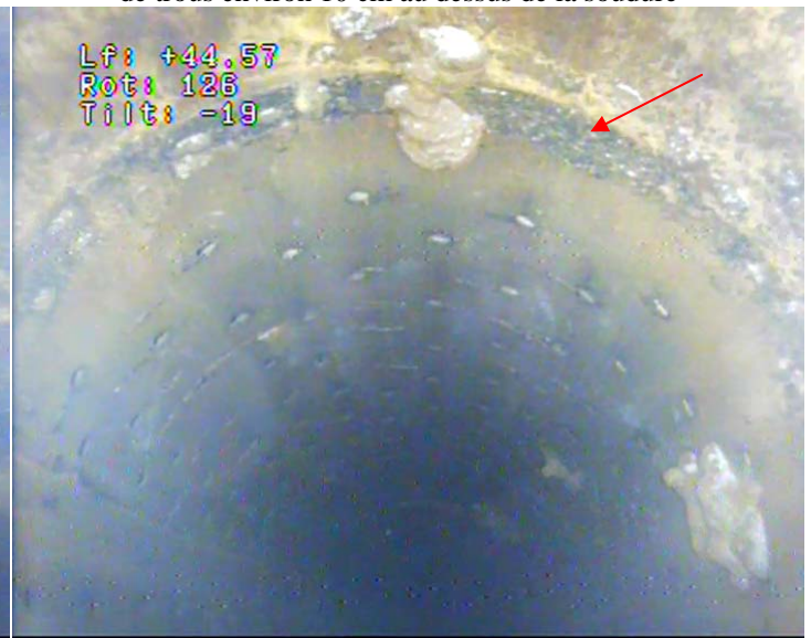
38 – Tubage acier en Ø 500 mm, soudure n°28 Début du deuxième niveau de crépine
