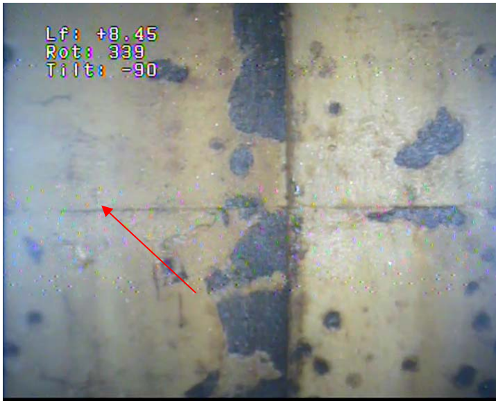
11 - Tubage acier en Ø 550 mm, soudure n°5
