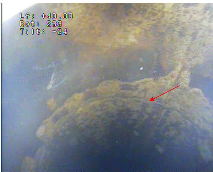
33 – Tubage acier en Ø 500 mm, soudure n°26
