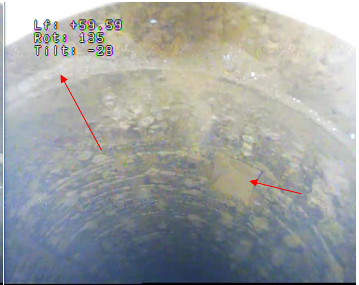
54 – Réduction tubage acier en Ø 500 / 450 mm Trou de manœuvre
