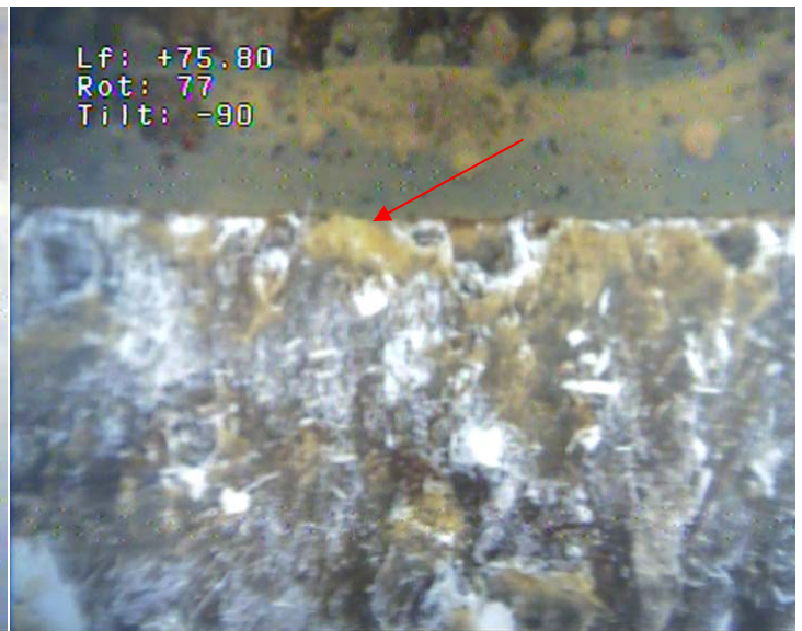
67 - Base du tubage acier Ø 450 mm
