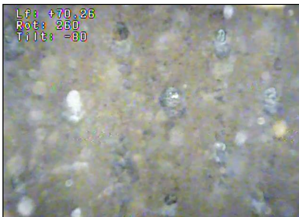
Photo 9 : Crépines peu colmatées à 70,3 m
